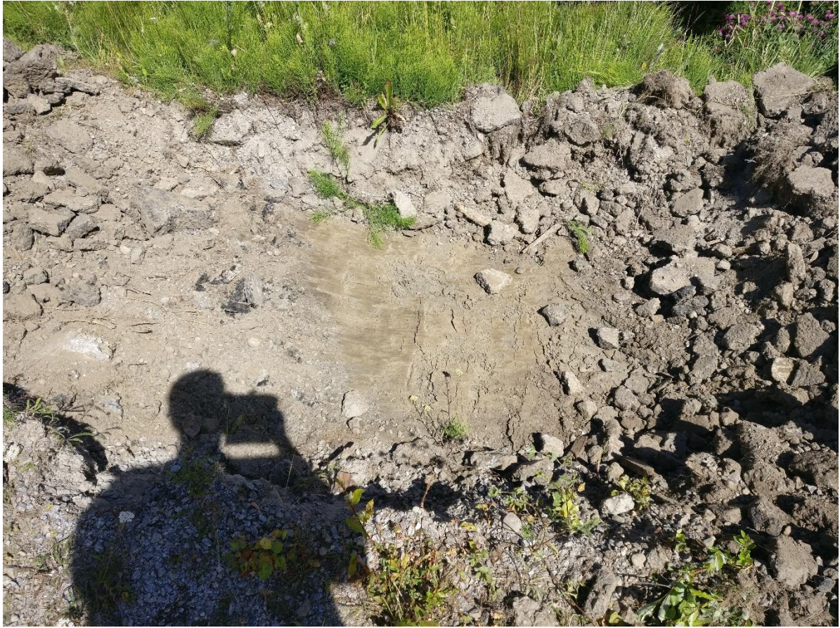
Kuva 1. Koekuopan 8 kaivettu kuoppa. Erityishuomiona on asfaltin kappaleet kuvassa kuopan molemmin puolin.
